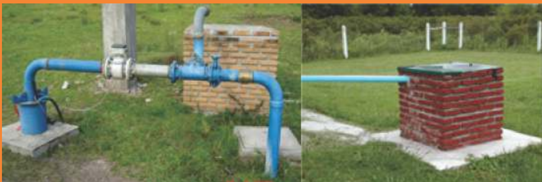
Figura 7. Protección Sanitaria, Cementado, Sello, Desinfección
